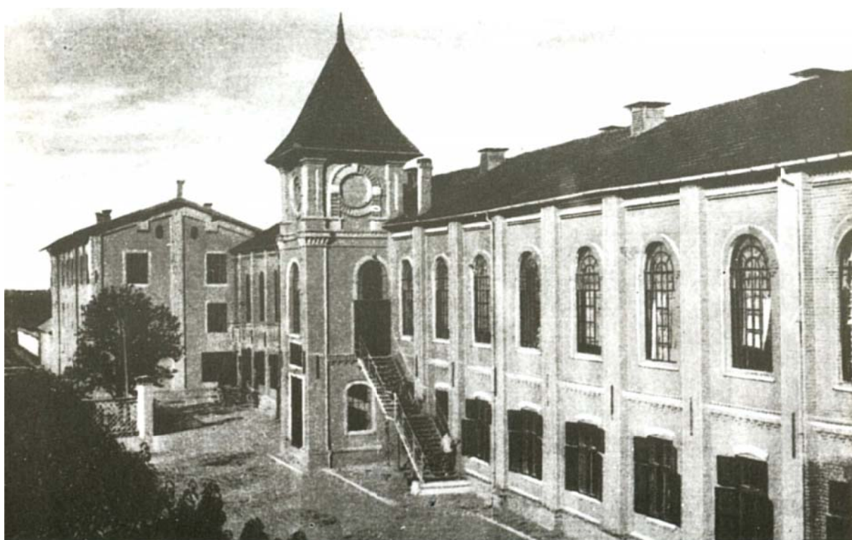
A tolnai selyemfonó épülete
